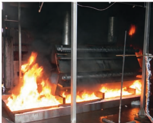
Principio d'incendio in un gruppo elettrogeno
